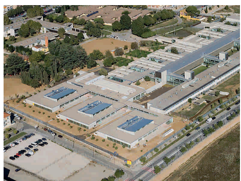
Vista aèria del nou Centre Sociosanitari
